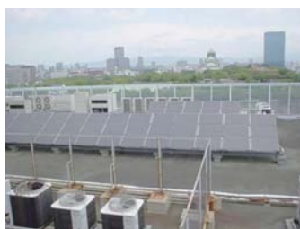
西日本本社馬場町ビル
