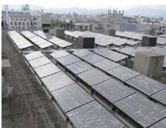
京都支店深草別館ビル
