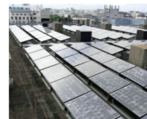
京都支店深草別館ビル
