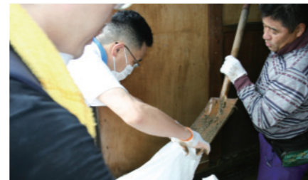
被災した家屋の土砂を撤去する社員たち
