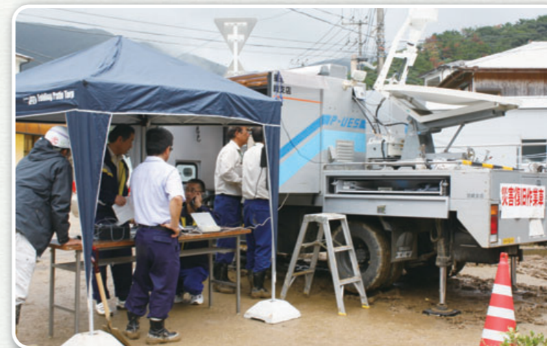
通信ケーブル接続作業の様相
