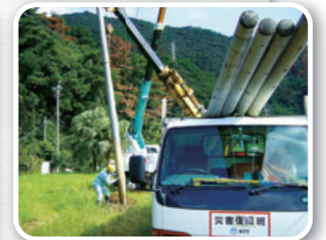
電柱の建て替え作業の様相
