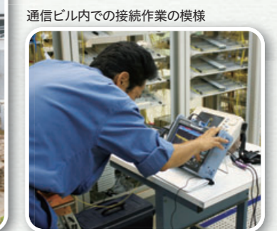
通信ビル内での接続作業の様相
