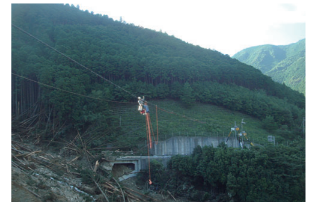
奈良県：中継光ケーブルの復旧のため、谷間にリード線を張り、宙乗り機でケーブルを敷設。
