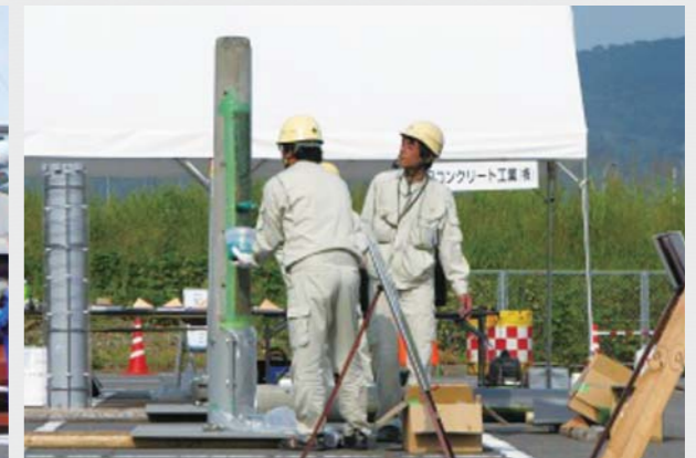
高圧ジェット水流を用いた電柱穴掘削方法の実演
