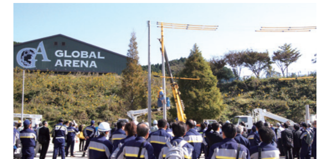
電柱抜柱の実演の様相
