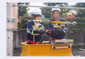
改良工具を使用したパケット車での作業
