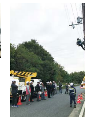
高所作業見学
