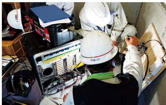
災害物資配付拠点における可搬型多重伝送装置施工の様子
